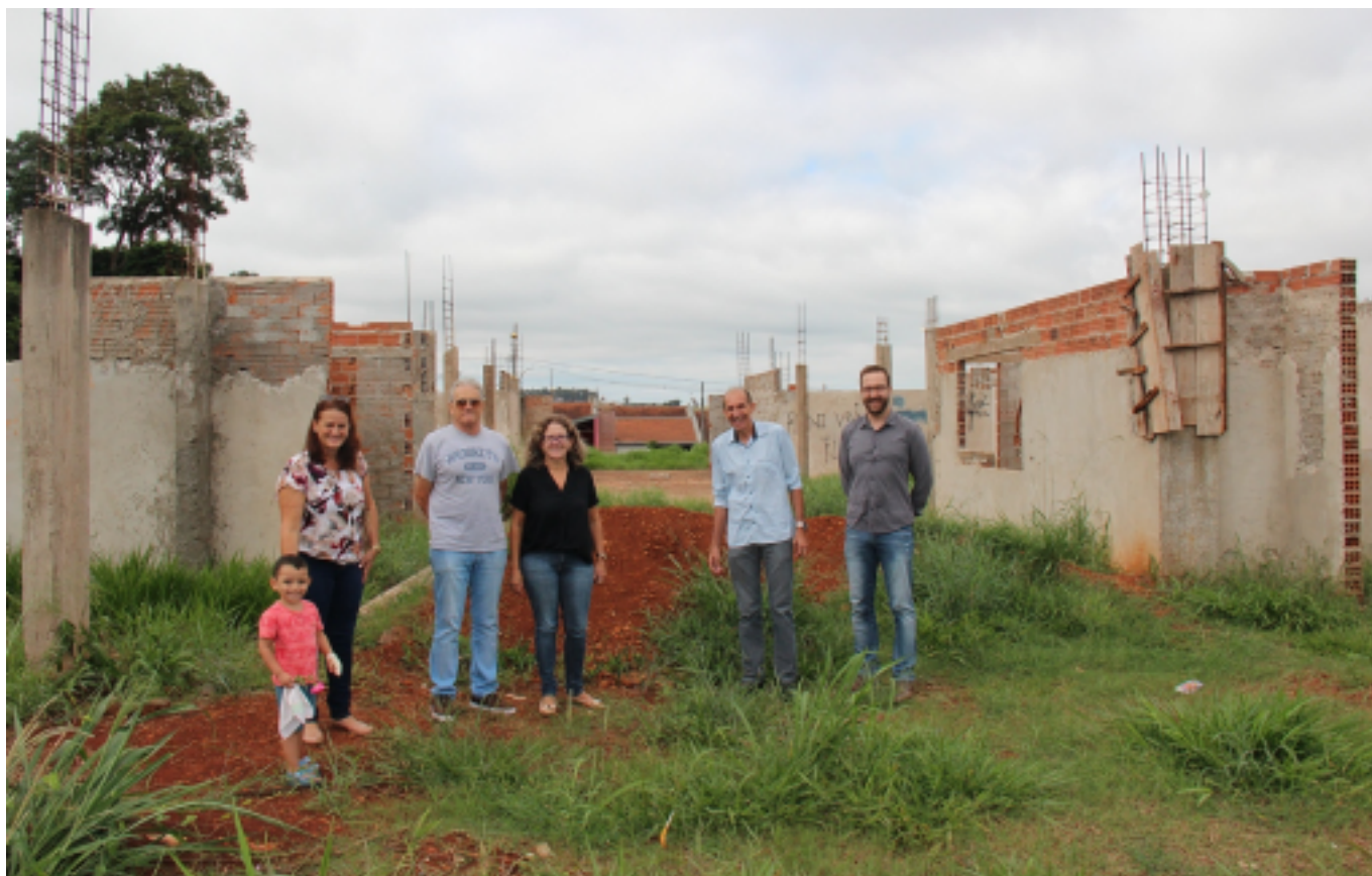
Vereadores então na CE visitam obra do CMEI do Pinheirinho em fevereiro
